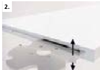
2. Отфрезеруйте паз P-System
